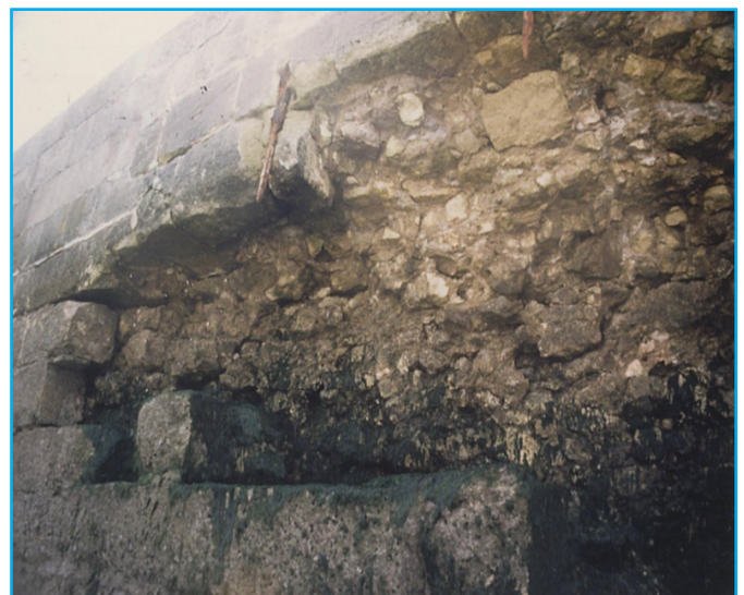
Figure 2 : Vue de la maçonnerie de remplissage derrière un parement endommagé
