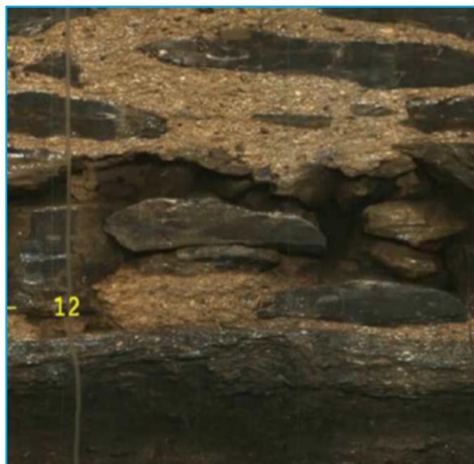
Figure 6 : Imagerie de paroi - Vue à 360° de l'intérieur d'un forage carotté
