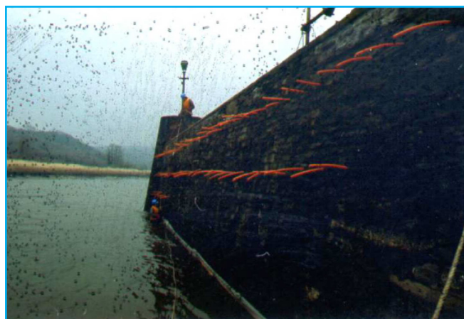
Figure 10: Exemple d'injection depuis le parement d'une jetée
